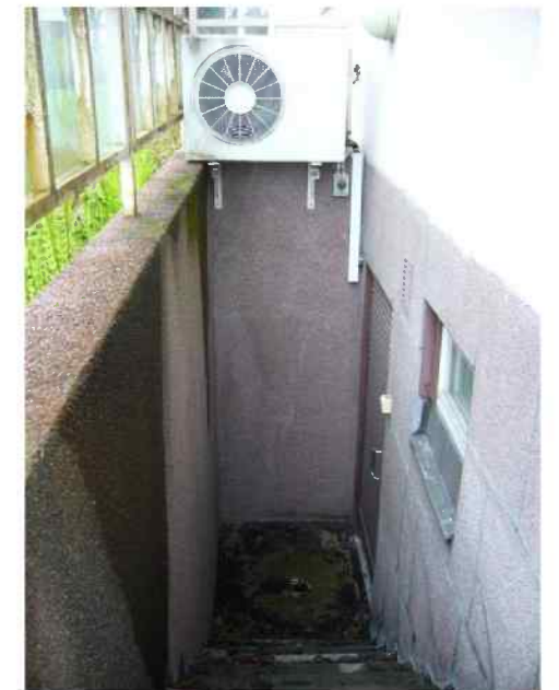
Kuva 61. pohjoisen puolella porras kellarin on katettu, samoin kellarin ikkunat. Uusia ilmastointikoneita on sijoitettu eri puoleille julkisivua; tässä kellarin portaaseen, muutoin katolle.
