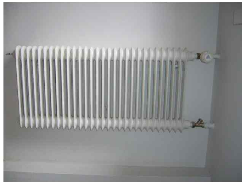
Kuva 61. Yläkerran aulassa, portaalla yläpäässä on mm. säilynyt vanha ripapatteri. Termostaatit on uusittu. Yläkerrassa on muissakin huoneissa vanhoja syvennyksiin asennettuja pattereita.
