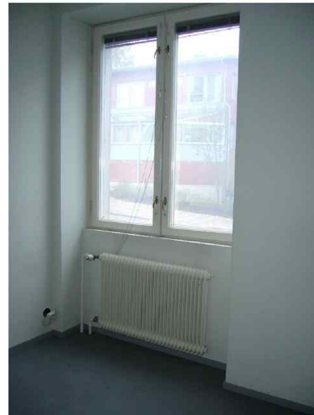
Kuva 71. Vanhassa päämassassa on säilynyt vanhat, ilmeisesti alkuperäiset ikkunat. Kuvassa ylhäällä vasemmalla nykyisen neuvotteluhuoneen, alkuperäisen ruokasalin ikkuna, josta nähdään uudisosan ikkunoita ja satamaa. Ylhäällä oikealla alkuperäinen ulkoseinäliiraja, jossa on säilynyt työhuoneiden välillä uudisosan ja vanhan osan välissä ikkuna, nyt sisätilassa. Alhaalla vasemmalla alkuperäisen sisäänkäynnin paikka, josta ovi on poistettu vuonna 1963 ja korvattu ikkunalla, joka on samanlainen kuin alkuperäiset ikkunat.
