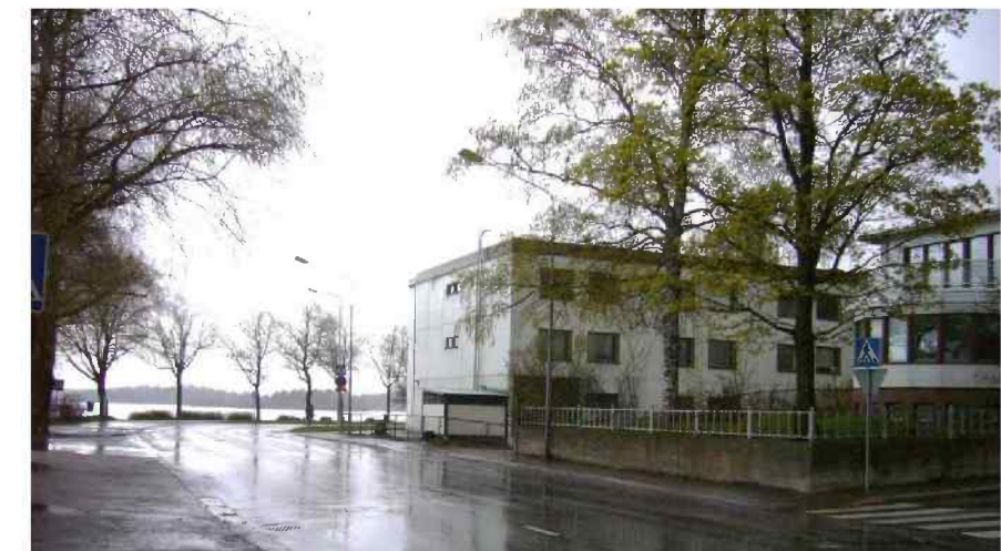
Kuva 19. Ainonkatua Neulasepänkadun risteyskohdalla pohjoiseen. Oikealla vanhan kappalaisen pappilan rakennuksen laajennusta ja naapuritontin 1970-luvun elementtirakenteinen kerrostalo.
