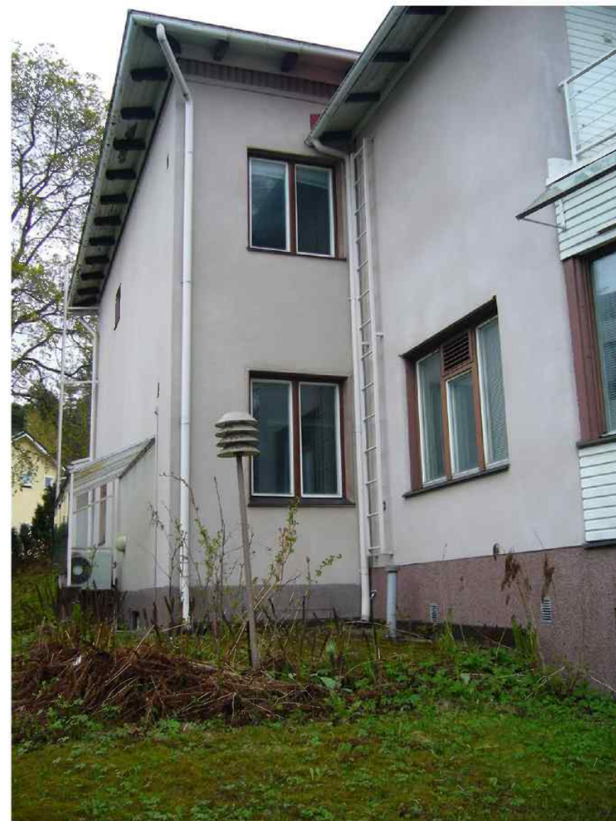
Kuva 54. Päämassassa ovat säilyneet kauniit alkuperäiset kattokannattajat ja hammersfriisi. Samaa aihetta on pelkistetysti varioitu uudisosassa. Alkuperäiset ikkunat ovat säilyneet ja niihin on osin vaihdettu selektiivilasit tai vastaavat auringonsuojat tuovat lasit ja alalistoitukset on puitteissa uusittu alumiiniseksi.
