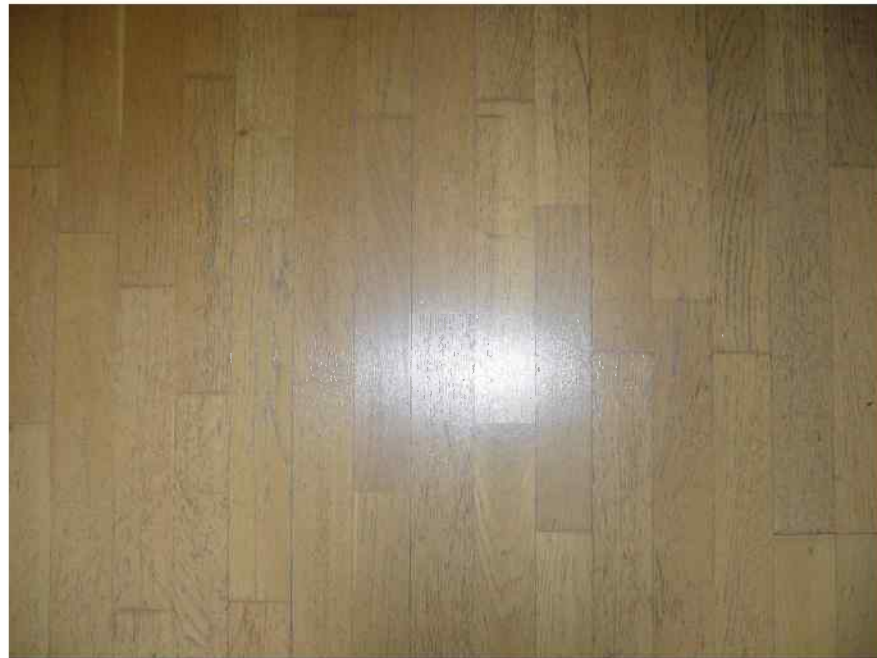
Kuva 72. Toisen kerroksen tiloissa on tammiparkettilattia. On hyvinkin mahdollista, että myös alkuperäisenä lattiämateriaalina on kappalaisen pappilassa käytetty tammiparkettia, joka tyyllisesti sopii rakennukseen hyvin, mutta oletettavasti tämä parketti on asennettu vuoden 1989 remonmtin yhteydessä, kun yläkertaan muutettiin toimistotilat asunnoksi.
