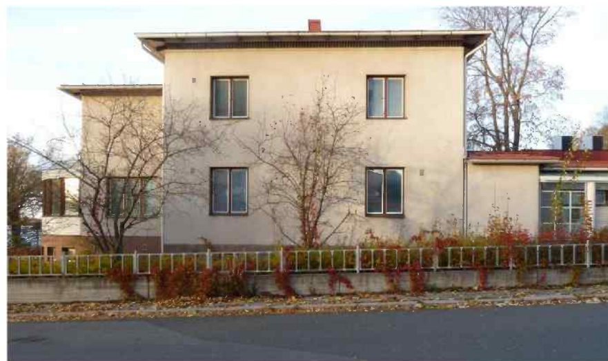
Kuva 50. Vanha päämassa erottuu korkeampana naapurilacjennusosien keskellä. Alkuperäinen sisäänkäynti oli nykyisen Neulasepänkadun puolelta, alimmassa kuvassa alimman oikeanpuolimmaisien ikkunoiden kohdalla. Tämä sisäänkäynti poistettiin jo ensimmäisessä remontissa vuonna 1963 eikä siitä ole enää muistumana muuta kuin eri tavoin smyykeistään käsitelty ikkuna-aukko.
