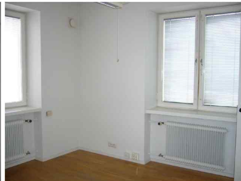
Kuva 61. Yläkerran aulassa, portaalla yläpäässä on mm. säilynyt vanha ripapatteri. Termostaatit on uusittu. Yläkerrassa on muissakin huoneissa vanhoja syvennyksiin asennettuja pattereita.
