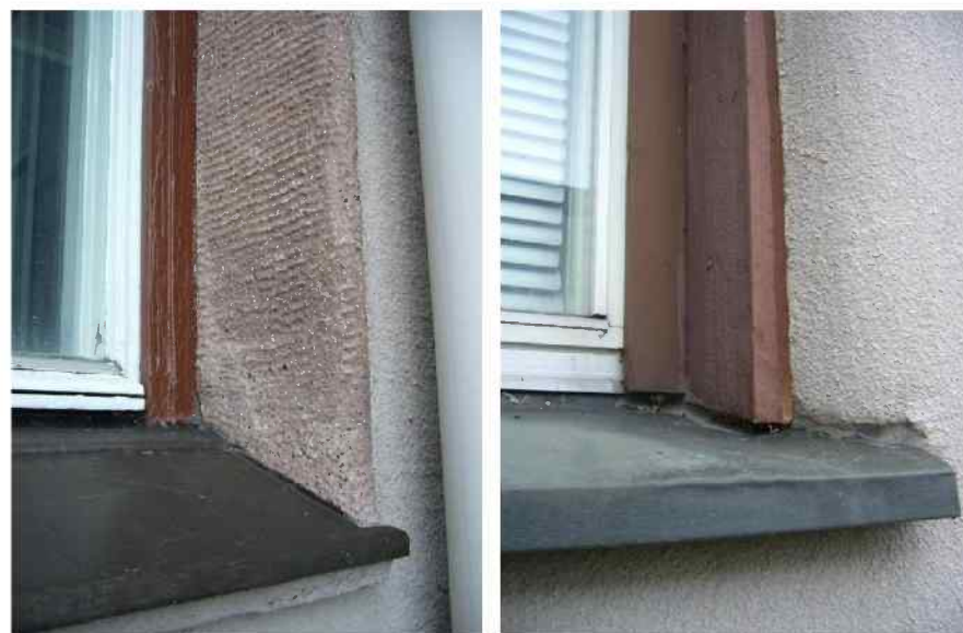
Kuva 53. Alkuperäiset ikkunat on smyykiosiltaan rapattu siten, että niissä on vaakauritus. Vanhan pääsisäänkäynnin kohdalla oviaukkoon on tehty ikkuna, jonka syvennyksessä on laudat ja julkisivu rappaus kääntyy kulman ympäri.
