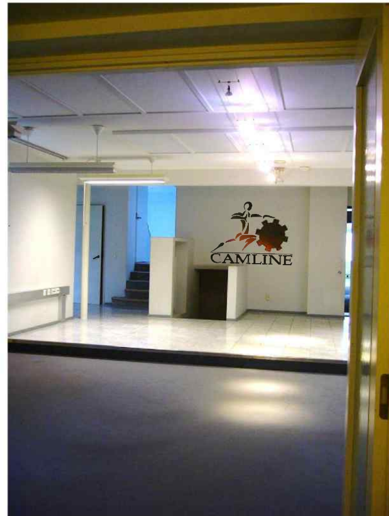
Kuva 62. Yläkuvassa uudisosaa ja käynti toimistotilojen välillä vanhan rakennusmassan itäpuolisessa osassa. Alakuvassa näkymä työhuoneista idästä lähteen kohti vanhaa päämassaa. Kevyet pilarit tulevat kantavaa runkoa vanhan ulkoseinän liirjassa. Portaat johtavat yläkertaan ja kellariin. Lattiamateriaalit ovat uusia.
