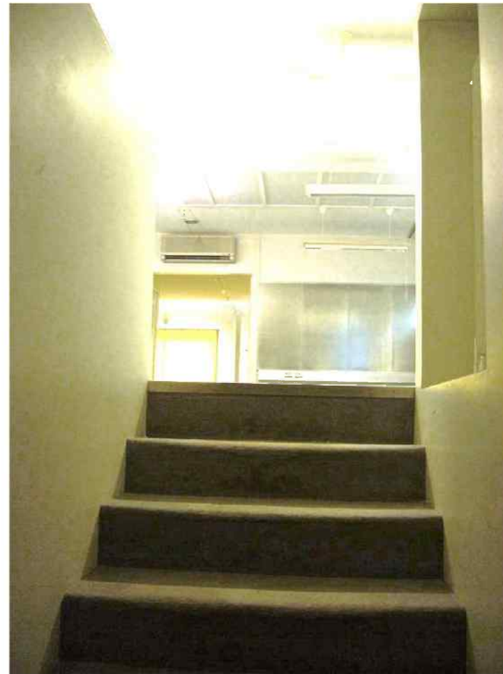
Kuva 68. Portaat kellarin ja ensimmäisen kerroksen välillä ovat kellarissa samalla paikalla kuin alunperinkin, mutta yläpäästään niitä on lupakuvien mukaan muutettu useaan otteeseen. Askelmat on verhottu kokolattiamatolla. Kuvassa näkymä kellarin portaasta kohti itäpuolen uudisosaa.
