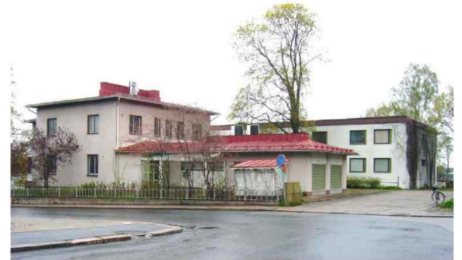
Kuva 49. Itäpuolelta autotallin ovet on vuoden 1999 remontissa muurattu lasitiiliin ja käyntiovet muutettu ikkunoiksi. Alkuperäisistä sisäänkäynneistä katoksineen tai parvekkeineen ei ole näkyviä muistumia, vaikka uusi sisäänkäynti pohjoisen puolella onkin käytännössä samalla paikalla kuin alkuperäinen keittiön sisäänkäynti. Betonilaatoitettu alue on Kimpisenkatua, joka paikan päällä hahmottuu tontinosana, mutta on jätetty ajasta, jolloin Kimpisenkatu liittyi pohjoispäästään Aionkatuun.
