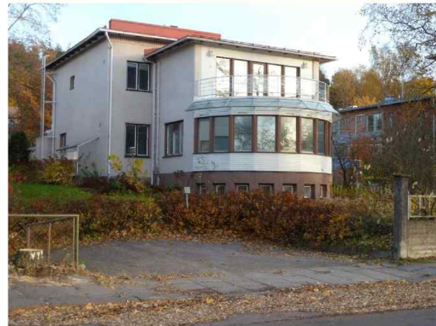
Kuva 48. Kuutiomainen päämassa, samoin kuin alkuperäinen kattomuoto, muotoiltuine kattokannattajineen ja hammasfriiseineen on säilynyt, vaikka rakennukseen on lisätty länsi- ja itäpuolelle uudisosat, jotka muuttavat rakennusta enemmän funktionalismin tyyliuuntaan ja tuo rantahuvilatunnelmaa puolipyöreine muotoineen ja reelinkikaiteineen.
